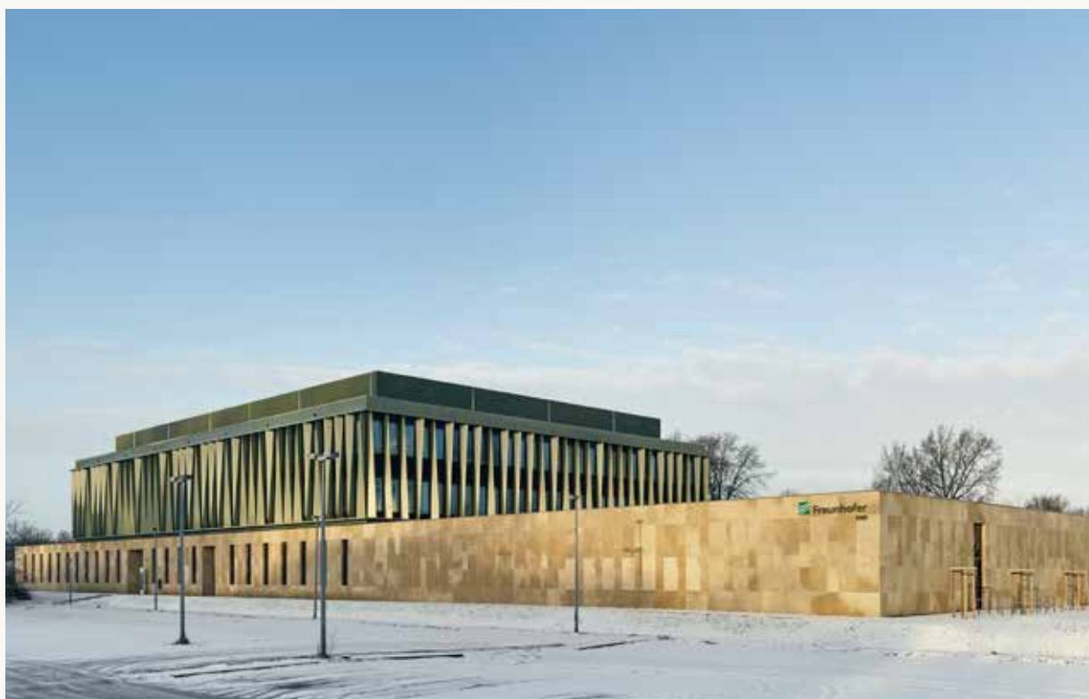
德国吕贝克海洋生物研究中心, 科研教学楼, 2014年 Lubeck Research Institute for Marine Biotechnology, Germany, R&D Building, 2014
